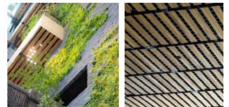
滝に近い天井ルーバー内のGWと壁面緑化の基盤により適度に吸音することで、3階以上の滝周りのカフェなどの滞在空間で目標値である50~65dBをクリアできるように計画した。
